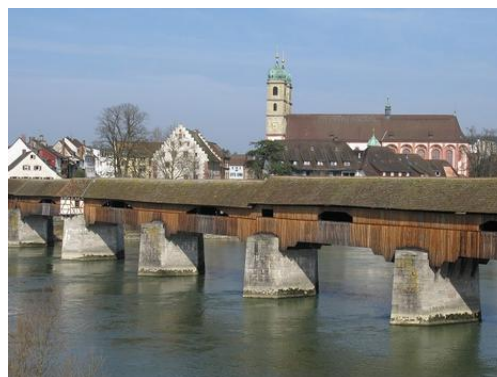
Brücke Bad Säckingen
